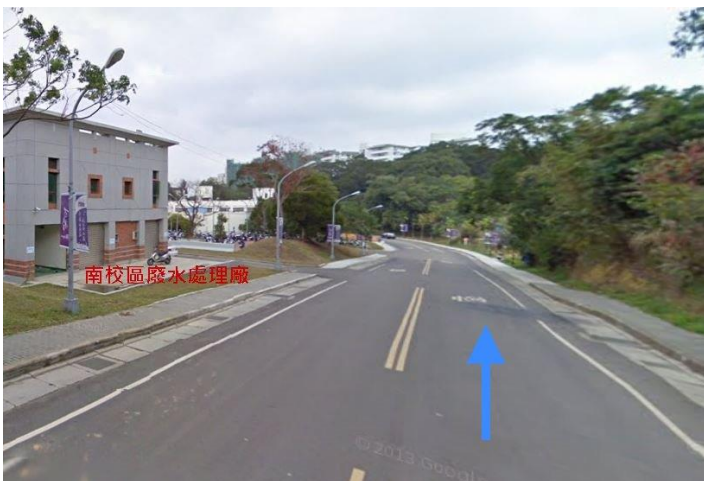
3. 舊南門入口→南校區廢水處理廠
