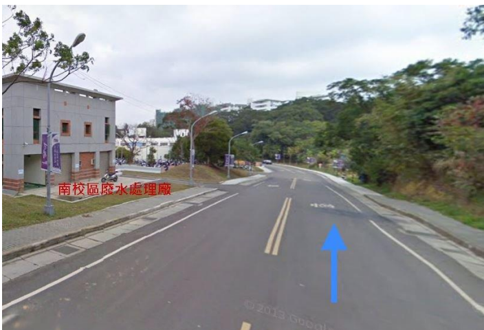
3. 舊南門入口→南校區廢水處理廠
